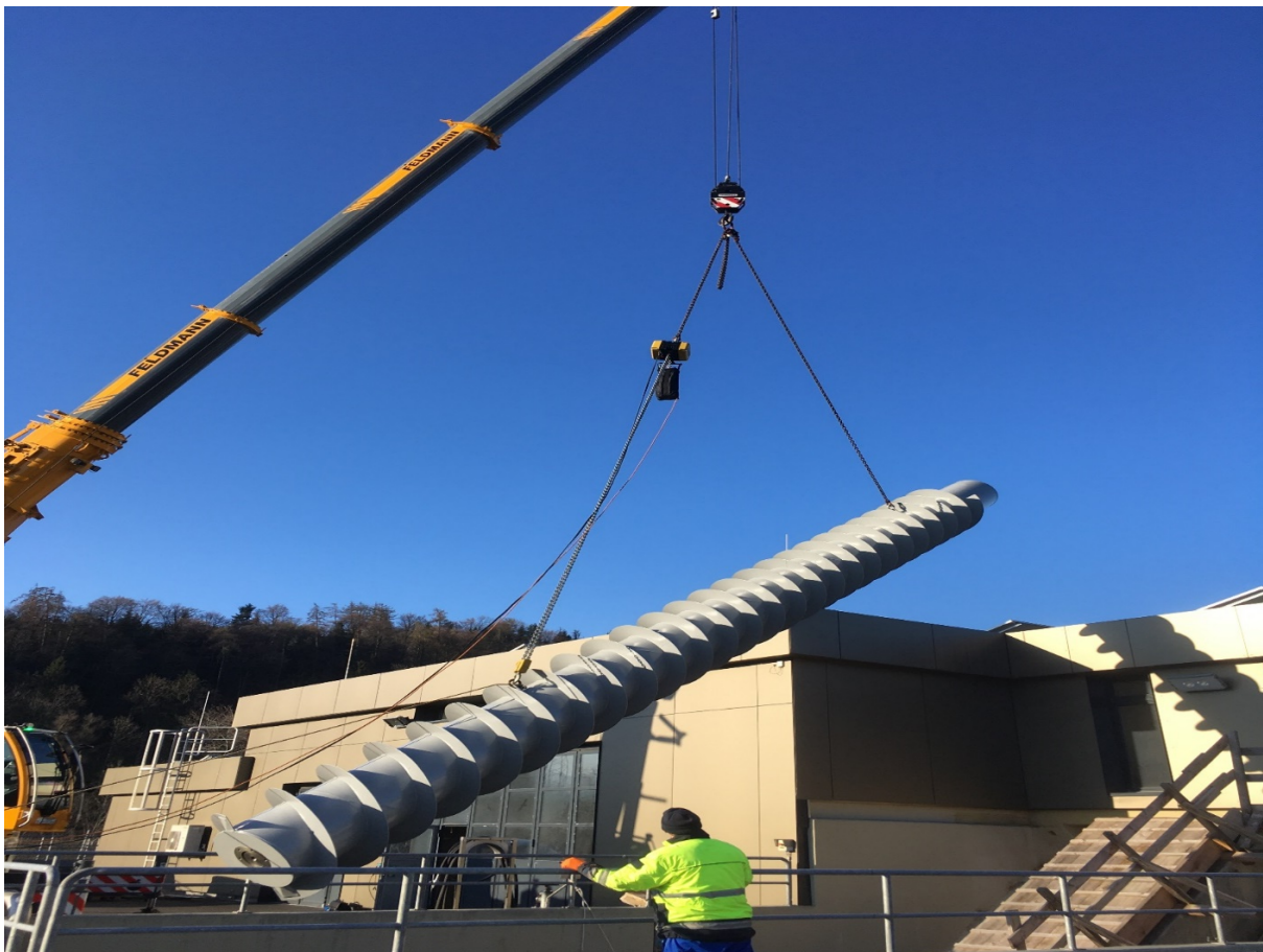
Einbau des neuen Schneckenpumpenkörpers
