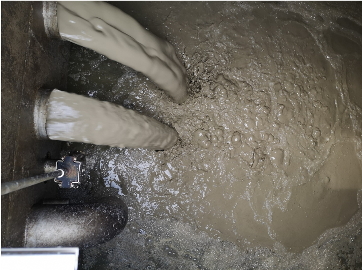
Frischschlammescht wird beschickt mit Bohrschlamm aus dem Vorklärbecken
