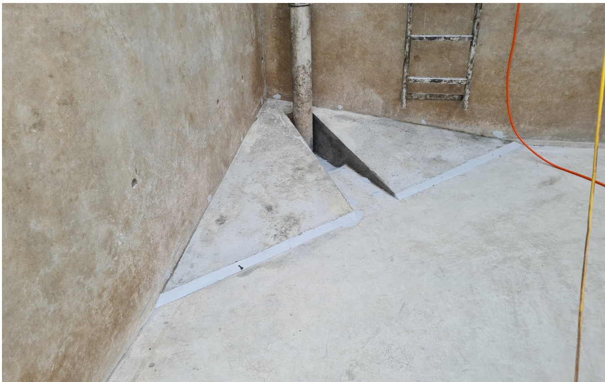
Auf Betonierung des Beckenbodens zur Verminderung von Ablagerungen
